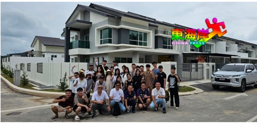
马中两国25名师生，参观大利宏愿集团新完成的一项双层排屋工程。
